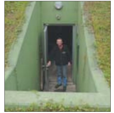
Im Riedhof Greppen wird Grundwasser gefördert.
