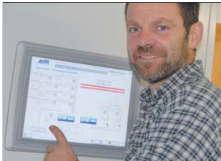
Reservoir Romiti: Brunnenmeister Beat Zimmermann erklärt die neue Steuerung.
