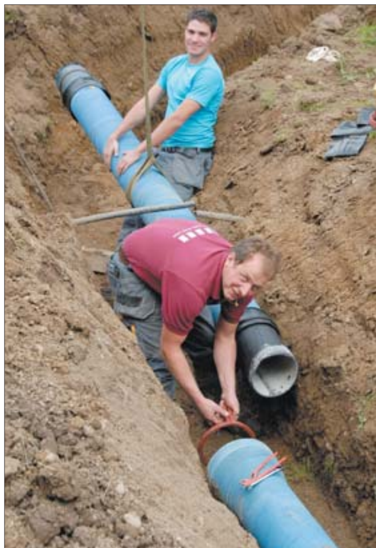
Für das neue Oberstufenzentrum Dörfli muss die Wasserleitung vom Reservoir Dörfli herkommend verlegt werden.
